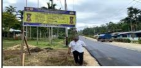
Kondisi Fisik setelah Pembangunan
